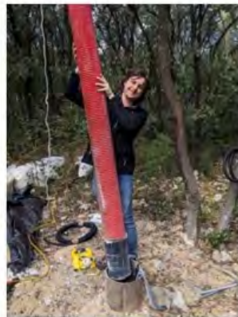
bouchon de béton (ep. 15 cm)
