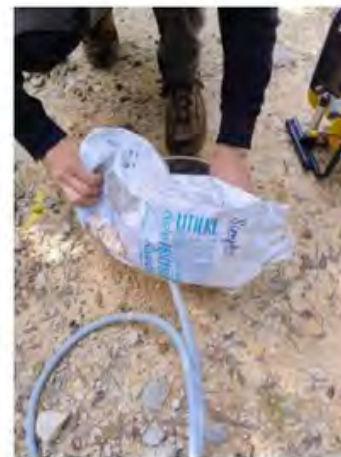
bouchon de bentonite (ep. 10 cm)
