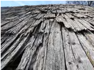
Echandoles et planches de toit en mélèze
