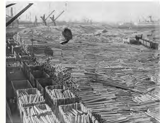
Déchargement des étais pour les mines de charbon du Pays de Galle, port de Cardiff, 1936.
