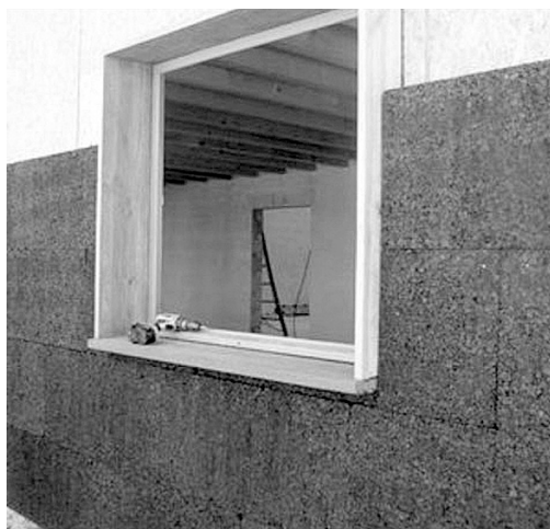
Photo : Isolation extérieure en panneaux agglomérés de liège Photo P.C.
