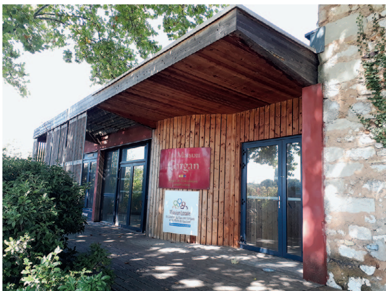
Photo 2 : Extension de la maison des métiers du patrimoine à Gargas (bardage et casquette en bois de cèdre). Photo P.C.
