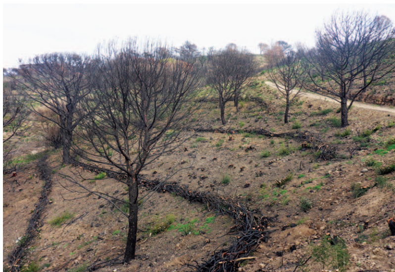
Photo 11 (ci-dessus) : Fascinage sur le site de Cap Lardier.
