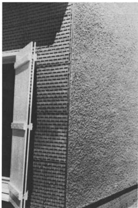
Photo 11. – A gauche, le treillis; à droite, l'enduit sur le treillis. Photo A. S.
