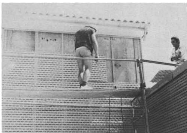
Photo 10. - Pose du treillis métallique sur la paroi de bois.
